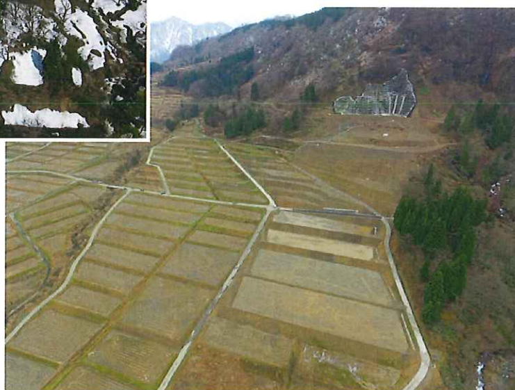
地すべり現場竣工 (H28年11月)
